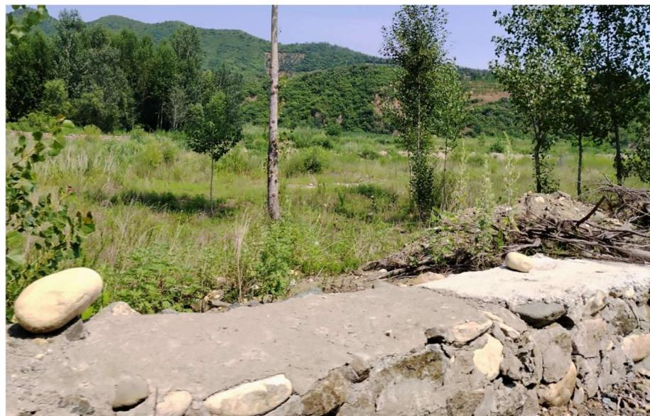
图3-5都源河三十六磙子村段河道右岸挡墙砌筑质量较差
