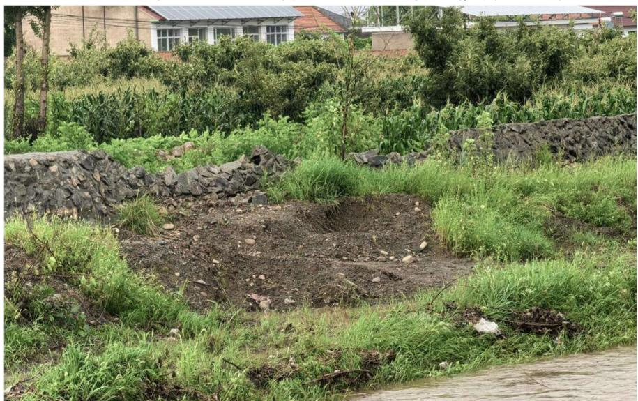
图3-4都源河马圈子镇段河道左岸挡墙局部破损
