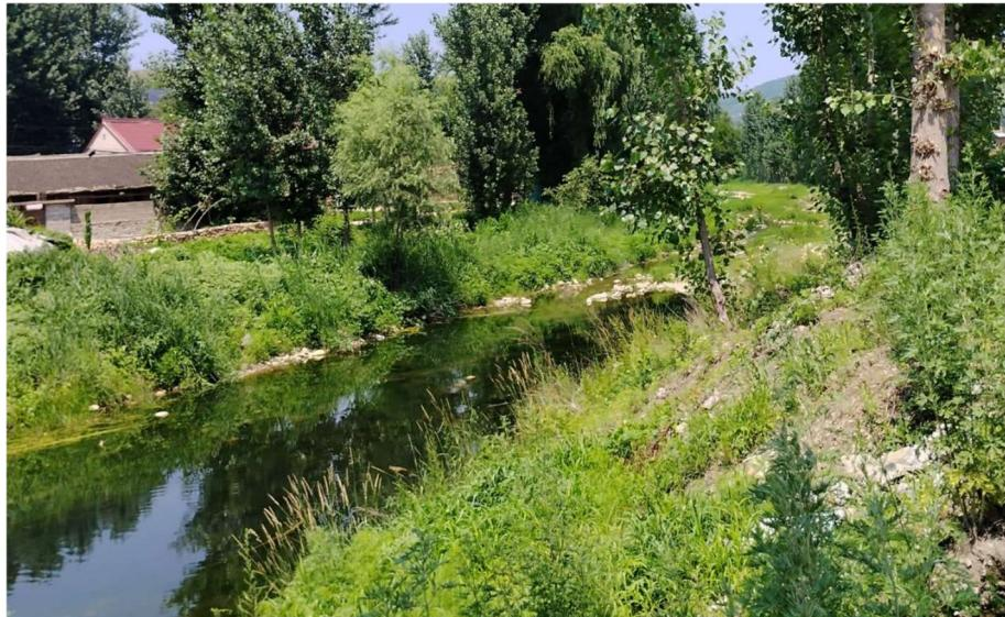
图3-9都源河下游段马圈子村河道右岸边坡无防护
