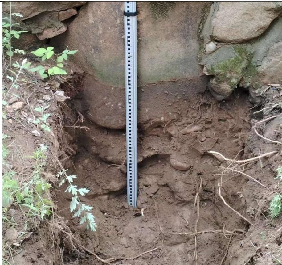
图3-6都源河三十六磙子村段河道右岸挡墙无基础埋深
