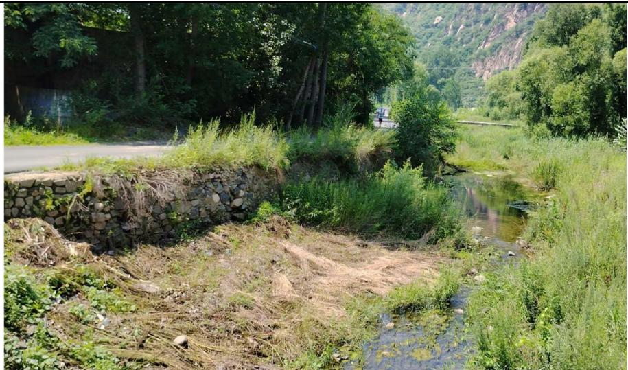
图3-3都源河三义合村段河道右岸挡墙倾斜、局部破损
