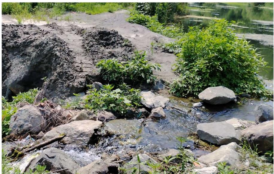
图3-2都源河下游沈杖子段河道卡口现状，尾矿堆积影响行洪
